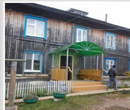
Ремонт и прокладка дорожно-тропиночной сети (ТОС «Берег»)
