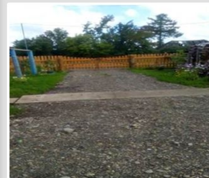
Ремонт и прокладка дорожно-тропиночной сети (ТОС «Родник»)
