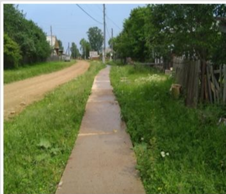
Прокладка дорожно-тропиночной сети (ТОС «Савинский»)
