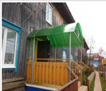
Ремонт подъездных крылец (ТОС «Берег»)
