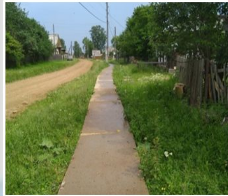
Прокладка дорожно-тропиночной сети (ТОС «Савинский»)
