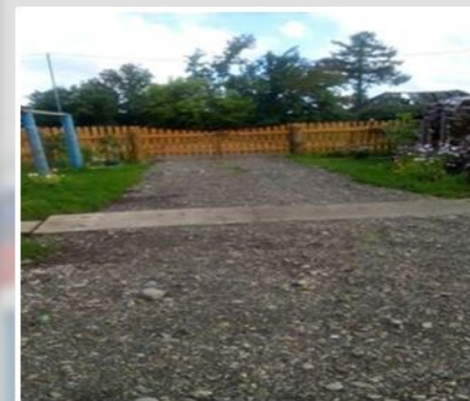
Ремонт и прокладка дорожно-тропиночной сети (ТОС «Родник»)
