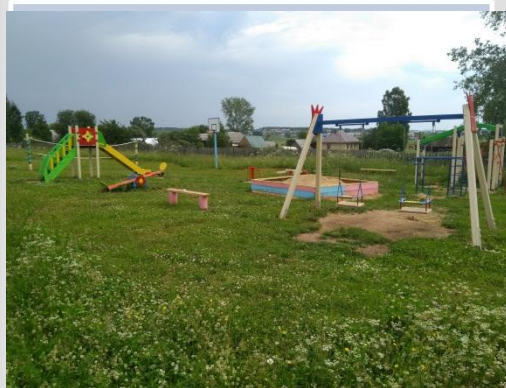
Строительство детской спортивной площадки (ТОС «Савинский»)
