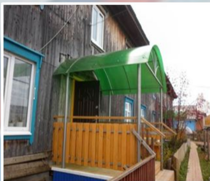
Ремонт подъездных крылец (ТОС «Берег»)
