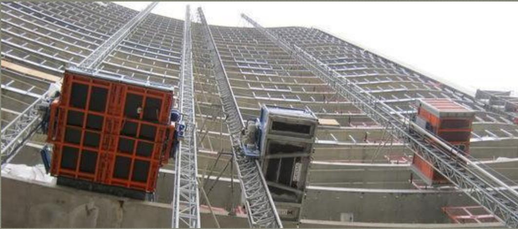
Для приема строительных материалов на этажах применяют грузовые площадки с ограждениями.
