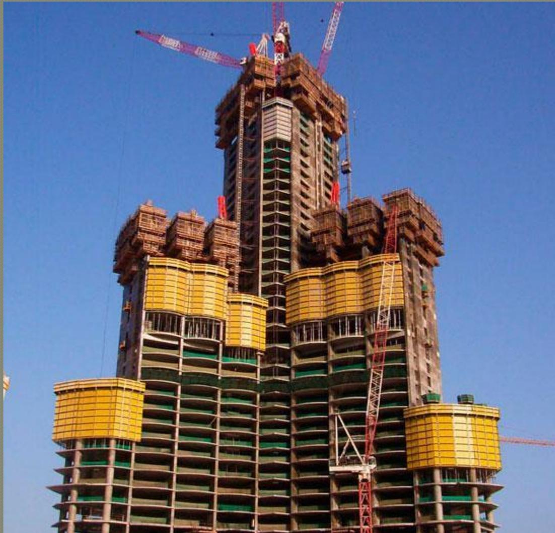
Монолитные перекрытия возводят в опалубке на основе телескопических стоек или опорных башен.
