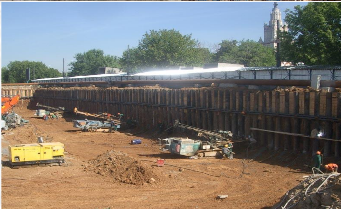
Установка анкерного крепления стенок котлована
