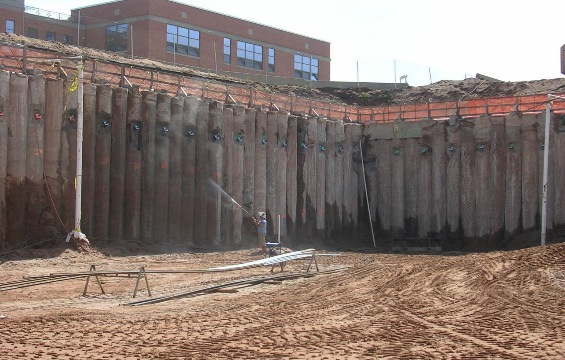
Постоянное закрепление стенок котлована касательными сваями и анкерами
