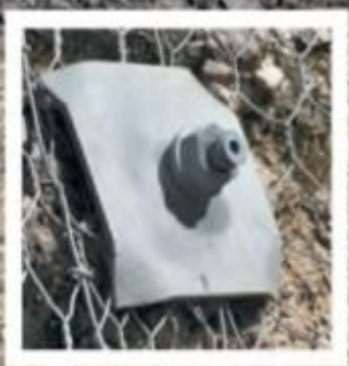
Головная конструкция для крепления металлической сетки
