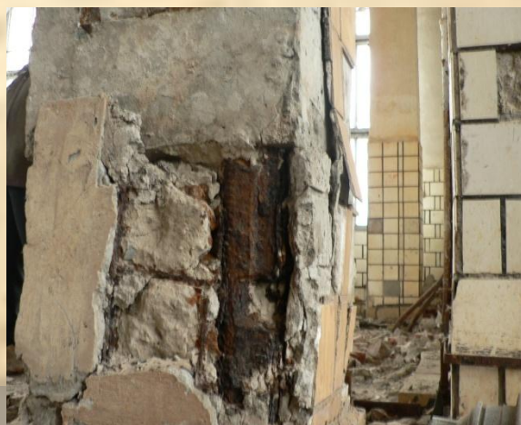
Колонна 2-го этажа
