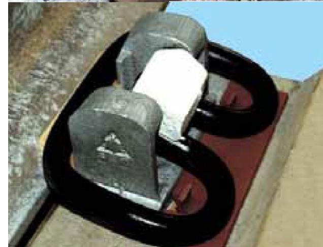
Рисунок 10 – Скрепление АРС:
