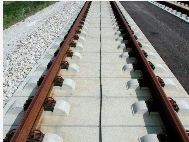
Рисунок 14 – Плиты безбалластного мостового полотна
