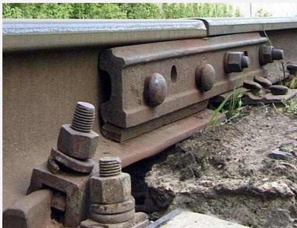
**Промежуточные рельсовые крепления** состоят из подкладок и прокладок, воспринимающих нагрузку от рельсов и передающих ее на шпалу; костылей (шурупов, болтов), которыми рельсы и подкладки прикрепляются к шпалам.
