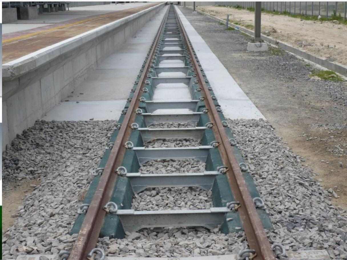
Рисунок 15 – Безбалластная система T-Track
