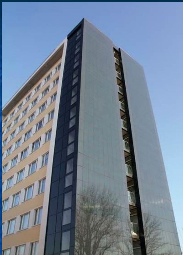
солнечные модули, встроенные во время термической санации здания Университета Эрфурта
