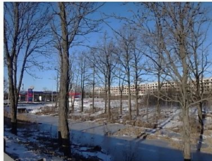
Вид на возведенные вчерне корпуса «Планетограда» сквозь зеленые насаждения (март 2018)
