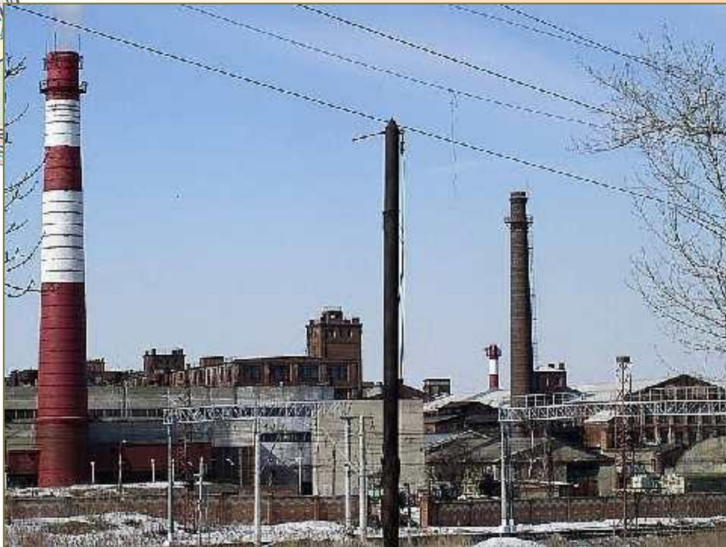
Подольск. Завод «Зингер».
