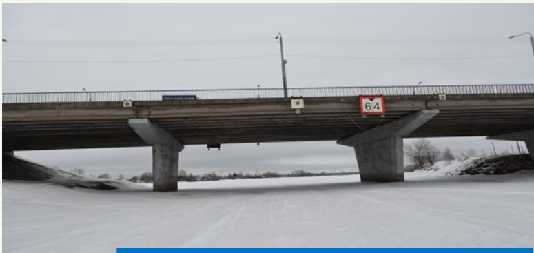
Ремонт Северного моста
