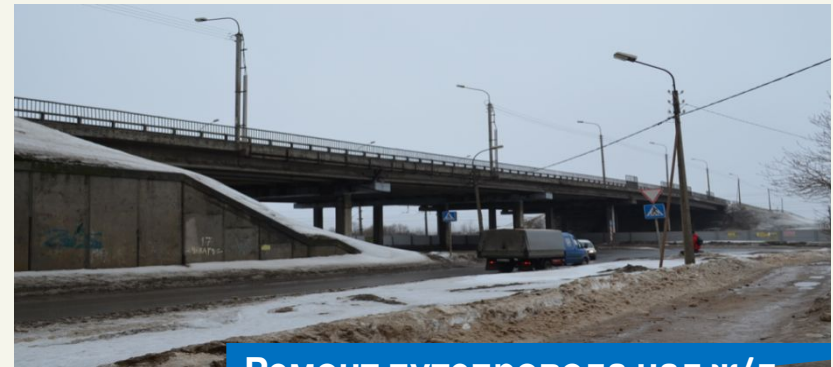
Ремонт путепровода над ж/д по ул. Архангельской
