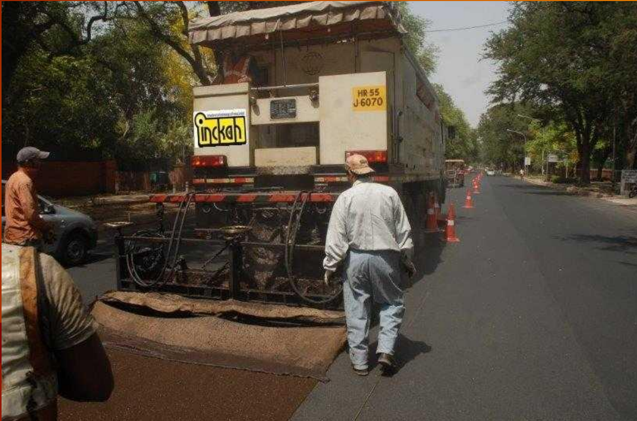
城市道路微表处预防性养护施工（印度新德里）
