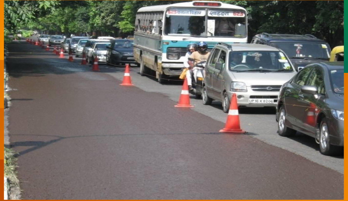
城市道路微表处预防性养护施工（印度新德里）
