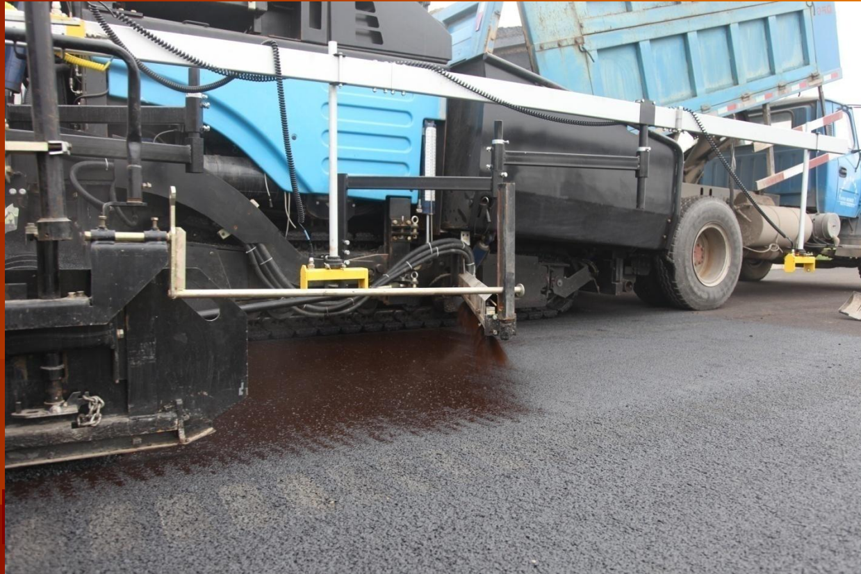
粘层洒布与混合料摊铺同步进行
