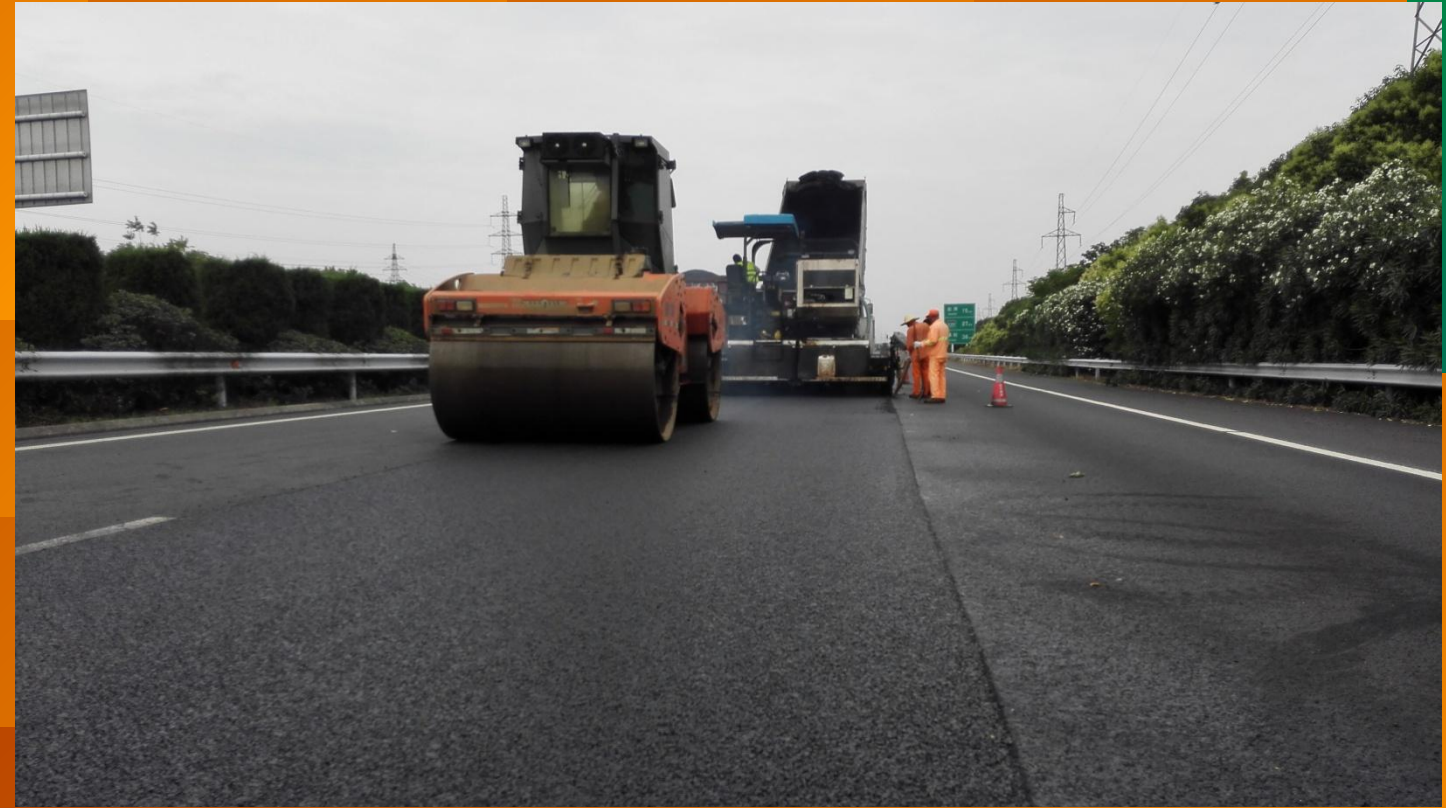
高速公路超薄罩面预防性养护施工
