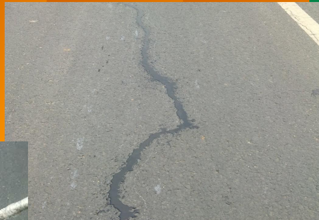
灌缝后的路面 После заливки
