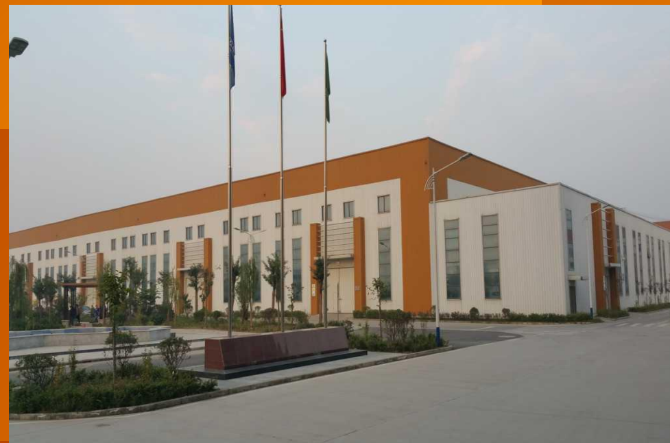
公路工程机械生产基地 3 号厂
