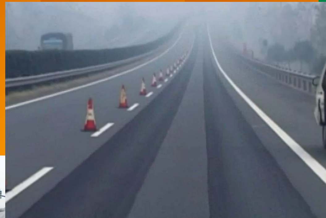
车辙修复后的路面 После реставрации колеи
