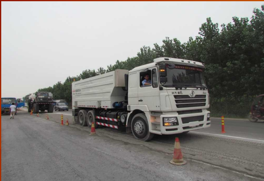
撒布水泥Разбрасывать цемент
