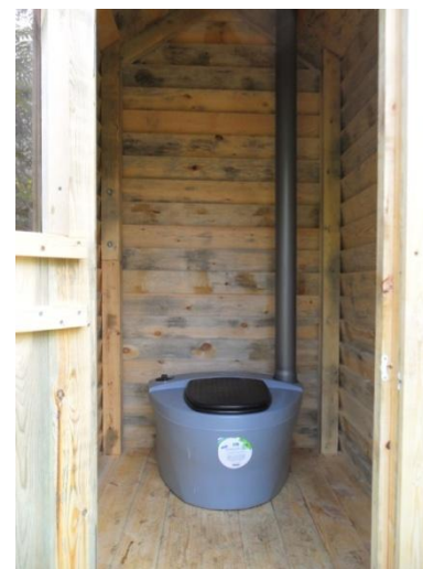
Установка компостного туалета у приюта «Медвежий угол»
