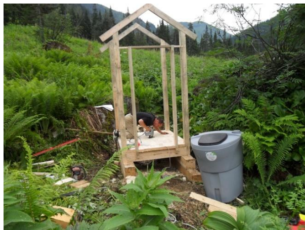
Установка компостного туалета у приюта «Медвежий угол»
