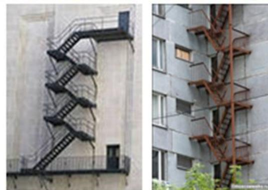
Несущие элементы эвакуационных путей, располагающихся на стене постройки, изготавливаются из металлических профилей, проектстальных труб или балок, соединенных между собой маршами и площадками из просечно-вытяжного листа и прессовочного решетчатого настила, обеспечивающего безопасность в холодное время года при образовании наледи.
