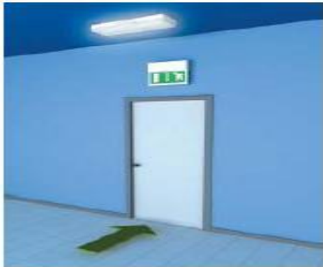
Над каждым выходом, используемым в качестве аварийного
