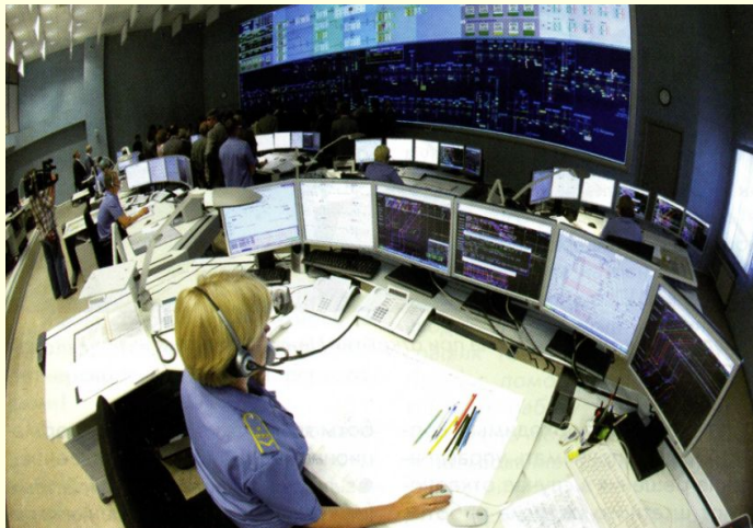
Ситуационный центр мониторинга и управления чрезвычайными ситуациями ОАО "РЖД"
