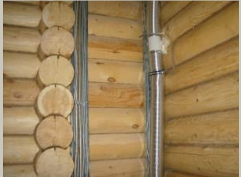
Монтаж линий электрики внутри деревянного дома
