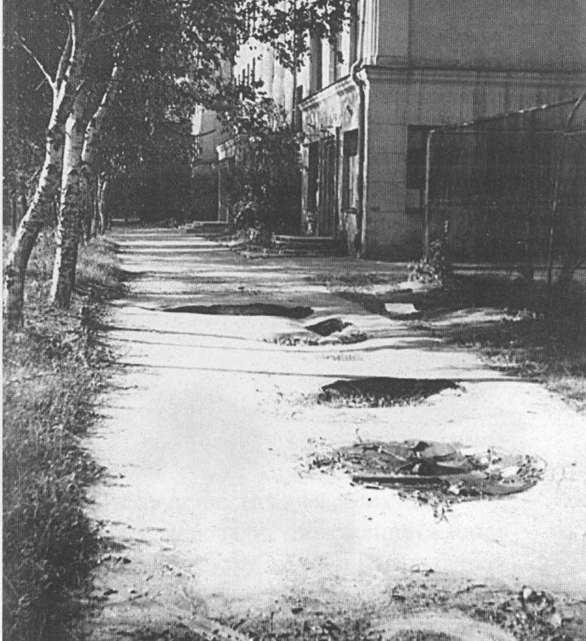
Рис.7.11. Суффозионные провалы над теплотрассой
