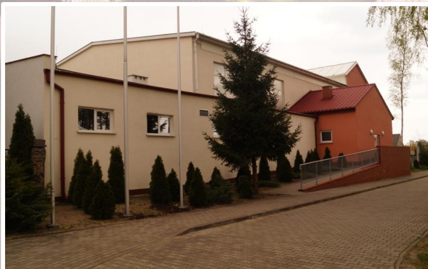
Budowa nowej szkoły
