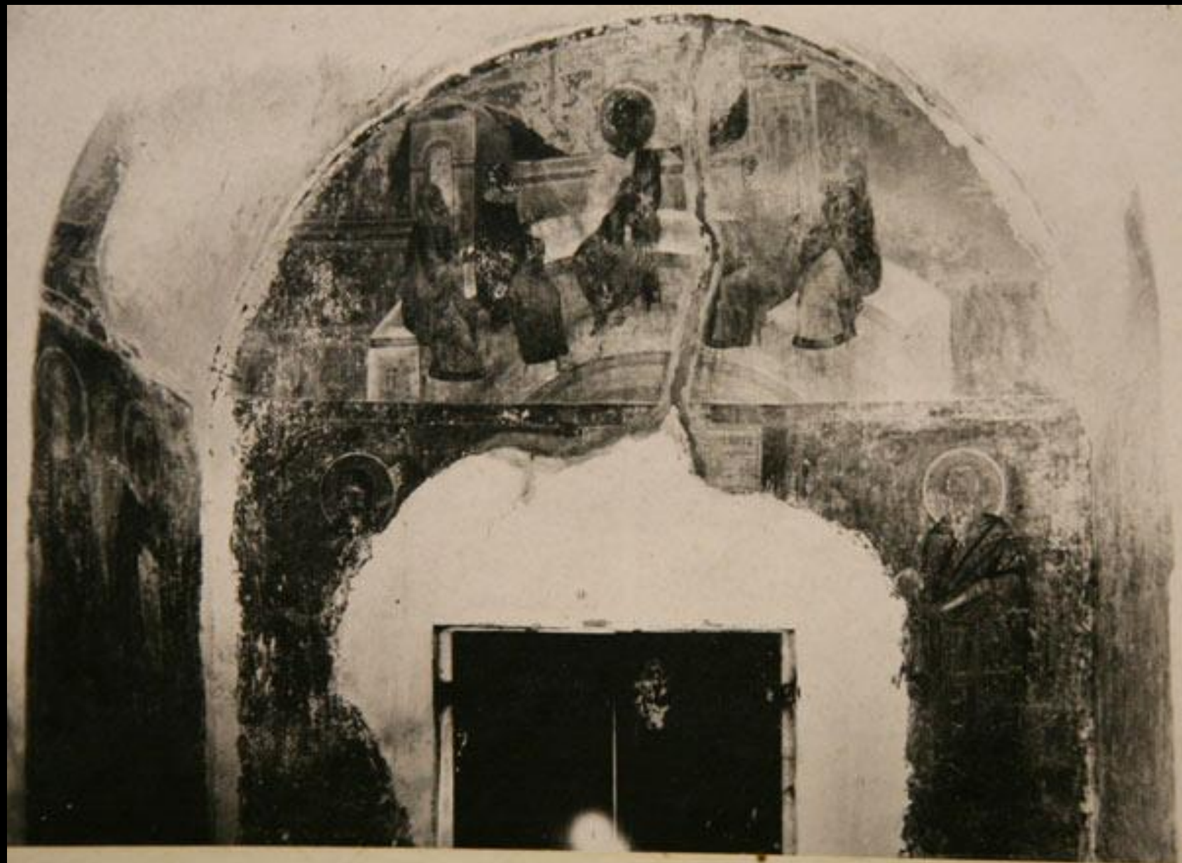
Вид западной части притвора до разрушения. Фото 1922 г.
