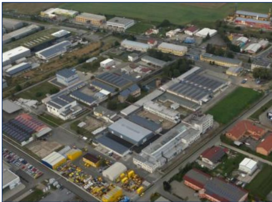
САФИХЕМ АССЕТС, производственные помещения, г. Вестец
