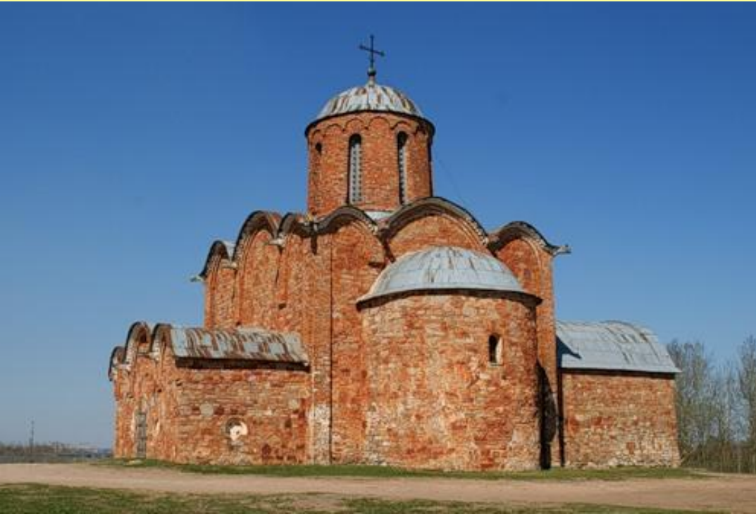
Церковь Спаса на Ковалеве. Новгород. 1345 г. Разрушена во время Великой Отечественной войны. Восстановлена реставраторами.
