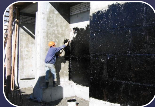
Строительство промышленных и гражданских зданий и сооружений
