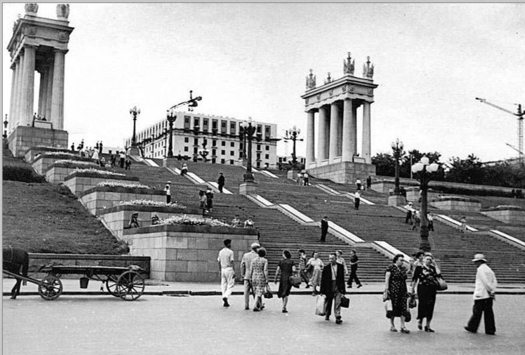
Центральная набережная, строительство дома по Аллее Героев, 2
