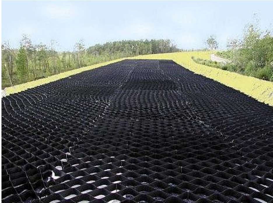
Армирование основания автодороги георешетками
