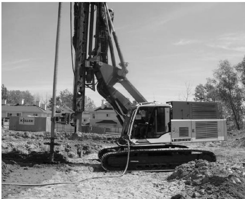
Буровая установка компании LIEBHERR (Германия)
