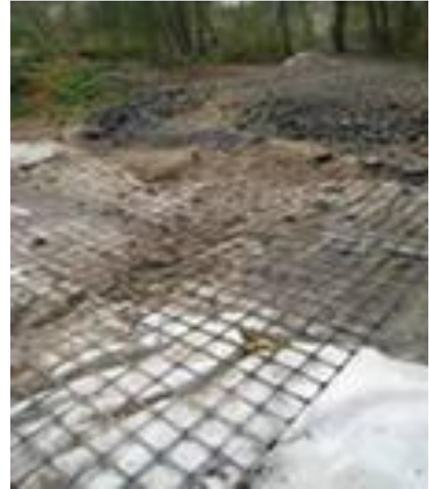
Применение геосетки при армировании основания
