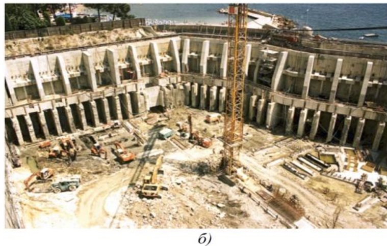
Рис. 1.42. Примеры стены в грунте с контрфорсами а) в Сингапуре; б) в Монако
