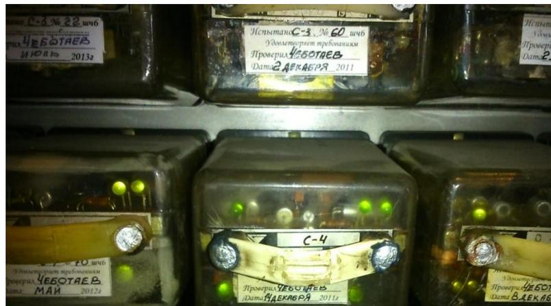
Если диоды не горят, проверить положение тумблера и исправность предохранителей соответствующих пути на блоке Б2 (блок питает блоки с4 путей) , при необходимости заменить с4.
