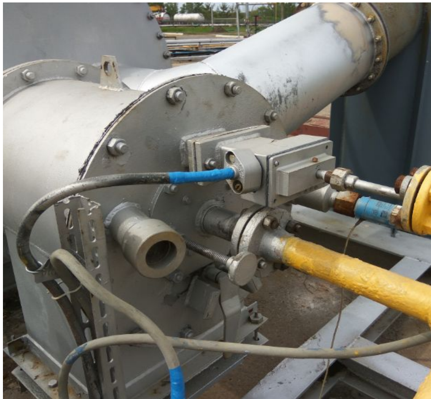
Рисунок 4 - Пилотная горелка с запальником
