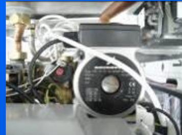
Открыть крышку насоса и повернуть ротор насоса по часовой стрелке на 1-2 оборота
