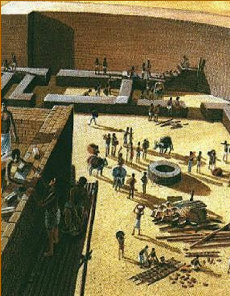
Возведение крепостных стен.
