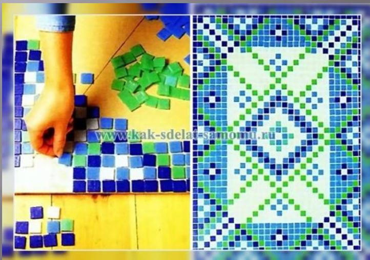
Частицы мозаики вдавливаются в заранее нанесенный на поверхность основания грунт по подготовленному рисунку. Грунтом может служить мастика, цемент
