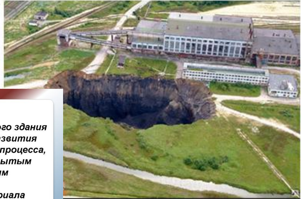
Трещина в грунте на территории завода «Уралкалий»
