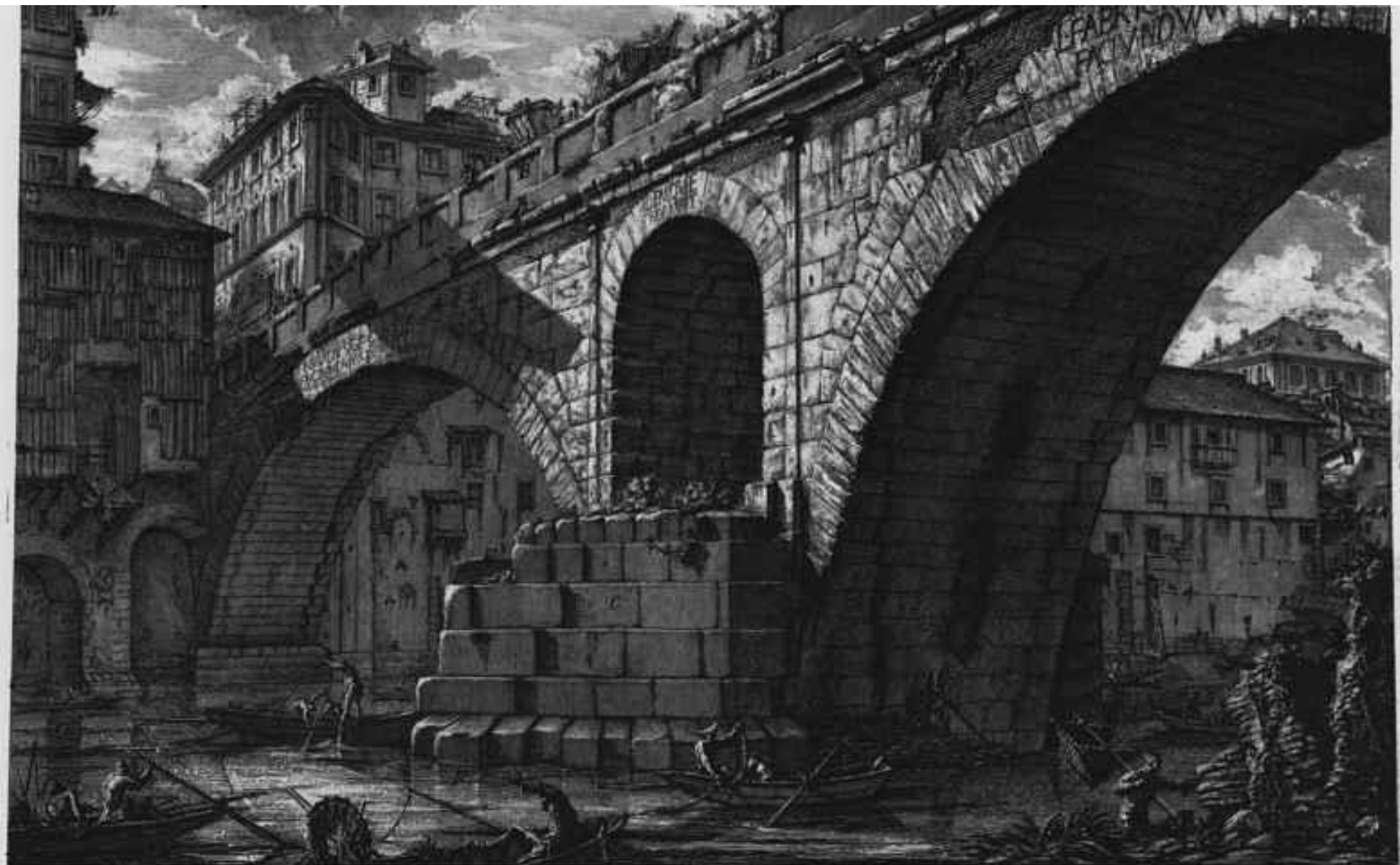
VISTA del Ponte Fabricio oggi detto quattro Capì. Questo Ponte è spogliato nel di sopra di suoi antichi Baluardi, et ornamenti, e quali per avventura restavano un' Opera intera, quale sopra dicea nel suo prim' essere stato. A. Spina moderna di Marmis in mancanza de' Trincerati antichi. B. Portico moderno di marmis * non fanno cancellati i Caratteri. C. Spina aggiunta da' Consoli posteriori a Fabricio. D. Spina che il muro intaco in D. non corrispondendo esso la prima fabbrica. E. Parte de' Muraioni portati via dall'acqua nell'incendio dell'anno santo 1722. F. Pila dell'acqua in tempo di S. Agostino. G. Caserme de' Soldati per guardia del Trincerato. H. Spina degli Orvi, et. Spinazione de' Cristiani attaccata a Marmis del Ponte, costruita sopra colli. I. K. Spina, e' spina della Pila, e' Pila del Portico dietro la scena del Teatro di S. Bartolomeo.
