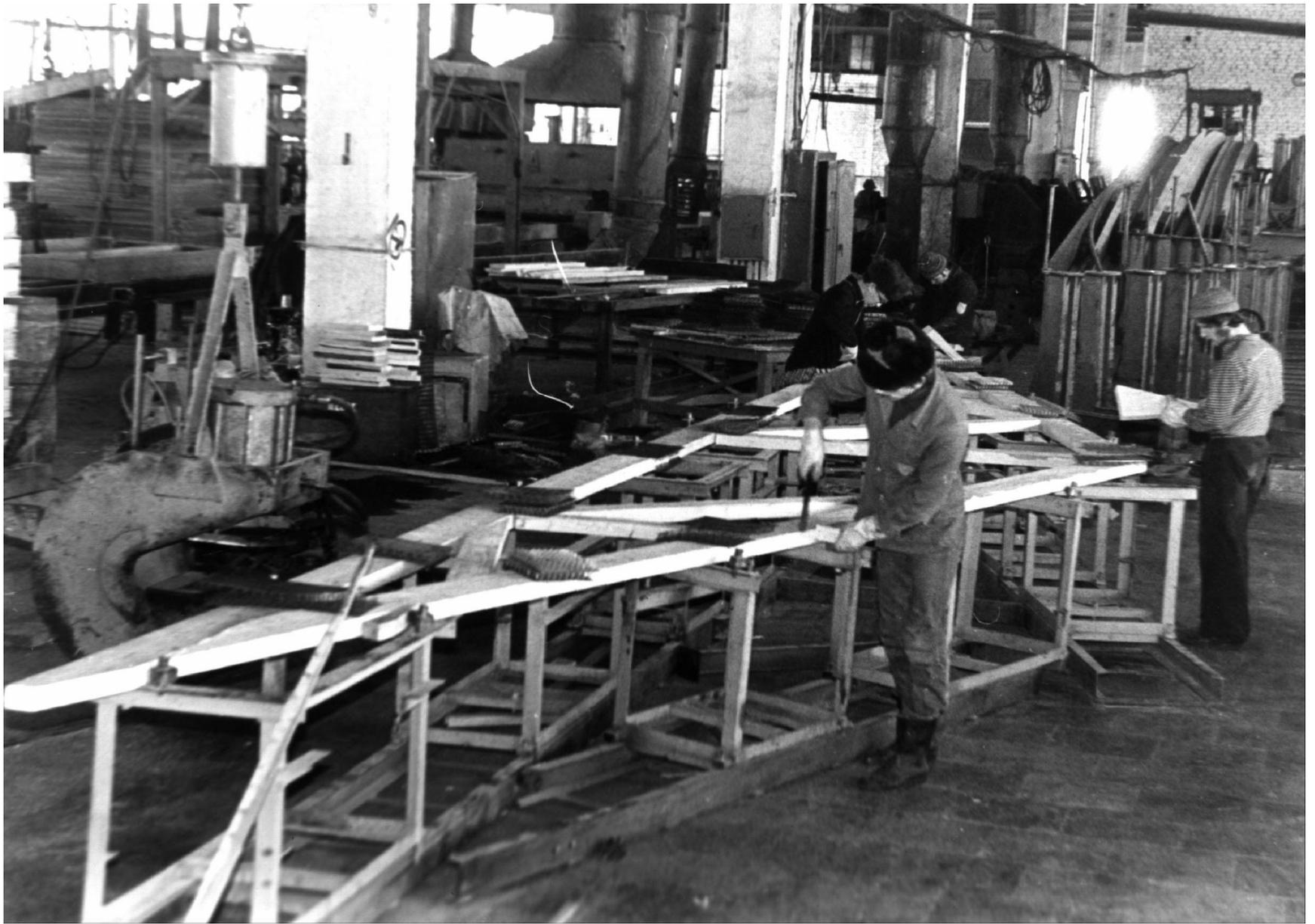
Процесс изготовления фермы на МЗП
