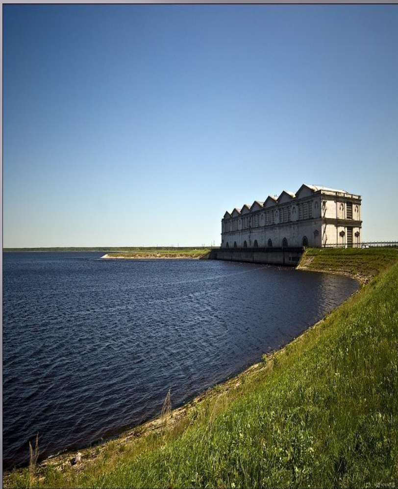
ГЭС на реке Шексне
