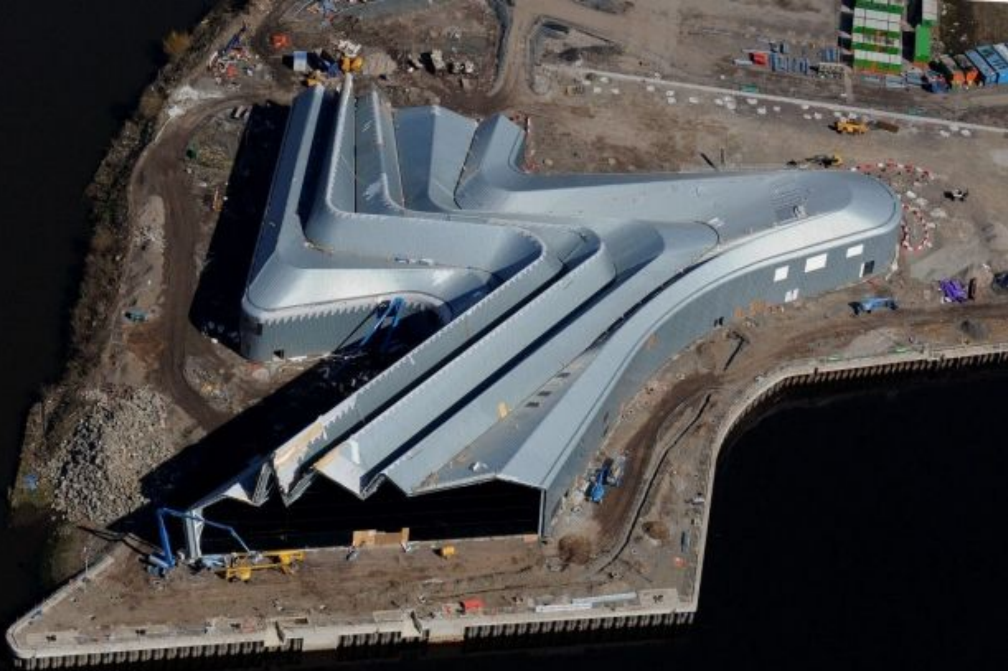
Музей Риверсайд в процессе строительства
