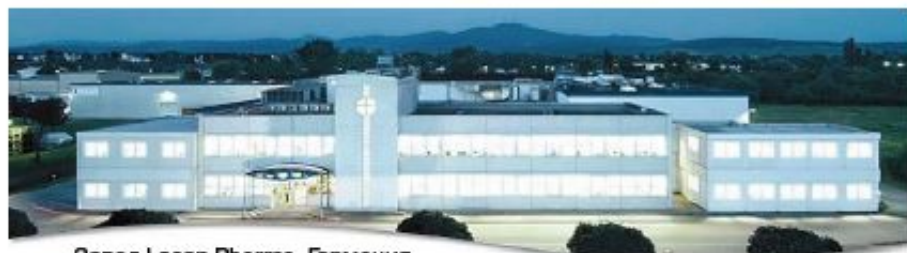
Завод Losan Pharma, Германия
