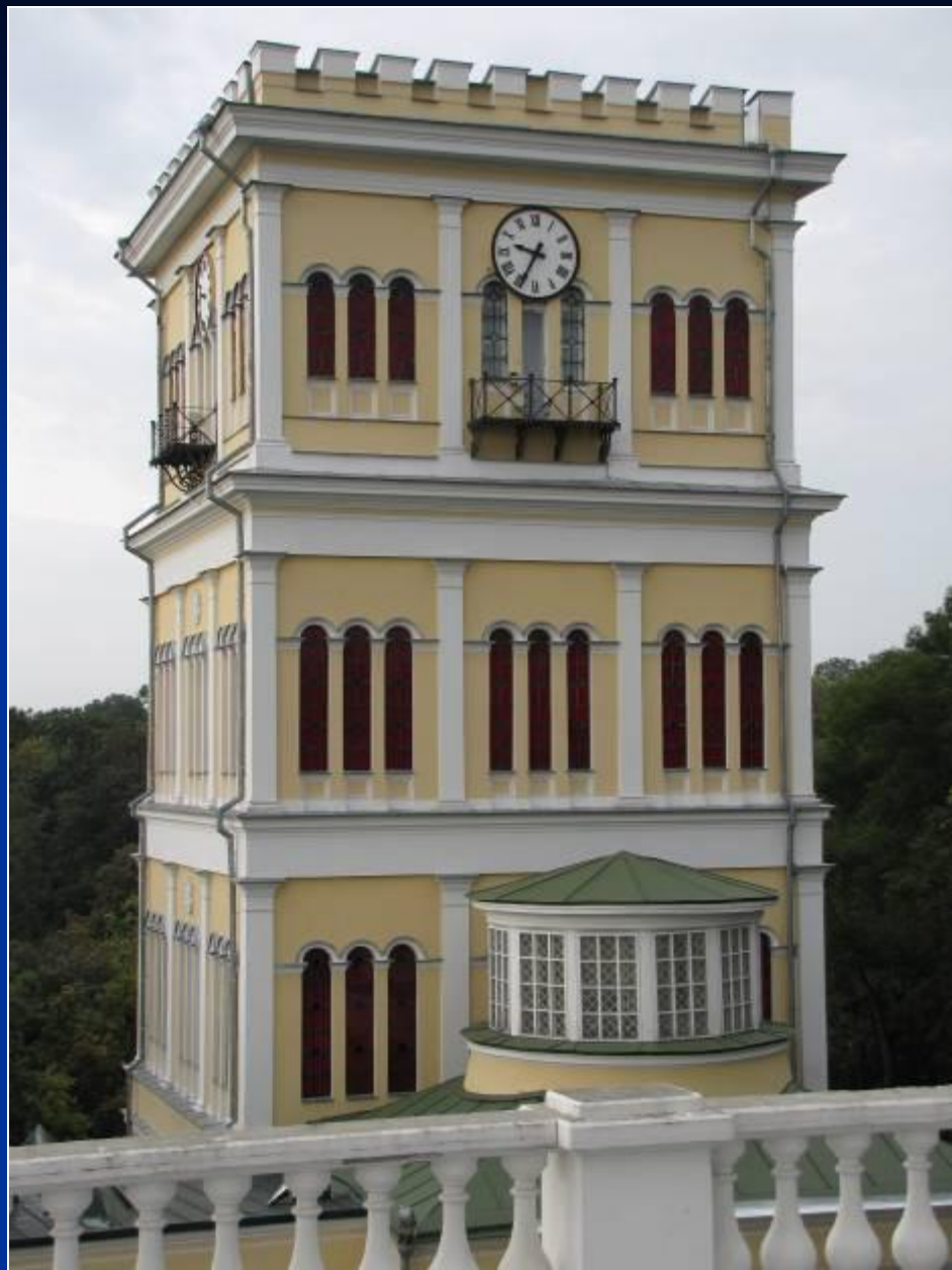
Башня дворца. Вид сверху
