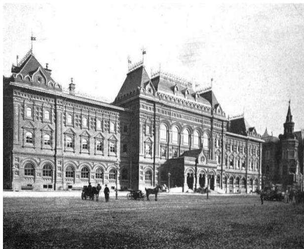
Здание Московской городской Думы, архитектор Д.Н. Чичагов
