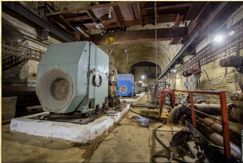
Водоотлив шахты "Южная"
