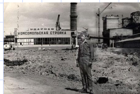
Новотульский металлургический завод,
