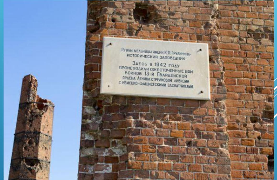
Здание мельницы — одно из первых в Царицыне, построенное по технологии несущего железобетонного каркаса и внешней оболочки из кирпичных стен.
