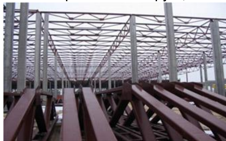
Металлоконструкции из профилей «Солар Стальконструкция»
