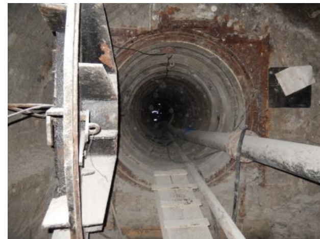
Вид со стороны рудника СКРУ-1
