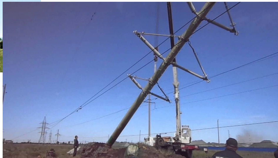
Установка опор из композитных материалов
