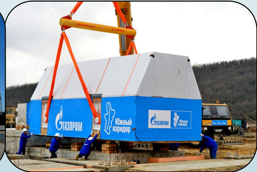
Установка компрессорной станции мощностью 32 МВт. Она будет прокачивать 63 млрд куб. м газа в год по дну Черного моря на расстояние более 900 км.
