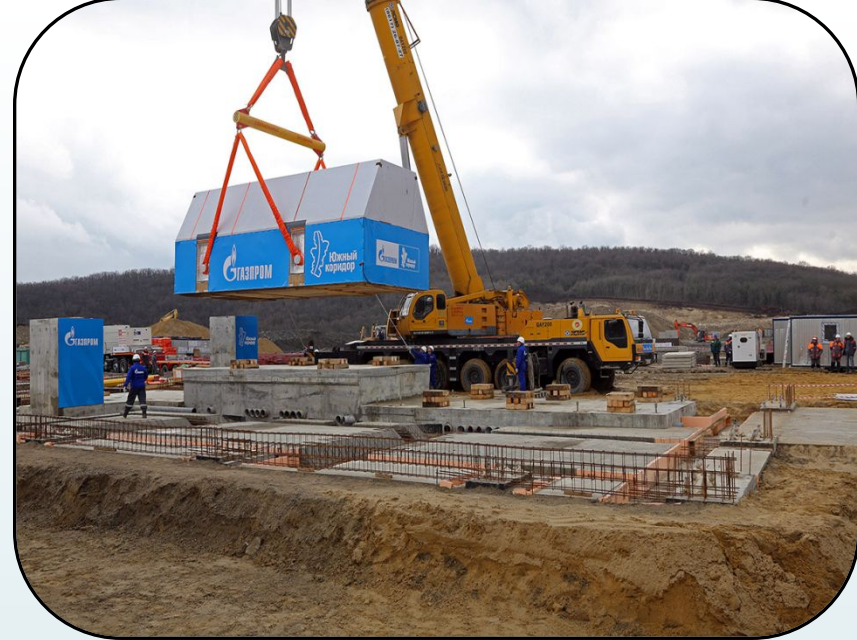
Установка компрессорной станции мощностью 32 МВт. Она будет прокачивать 63 млрд куб. м газа в год по дну Черного моря на расстояние более 900 км.
