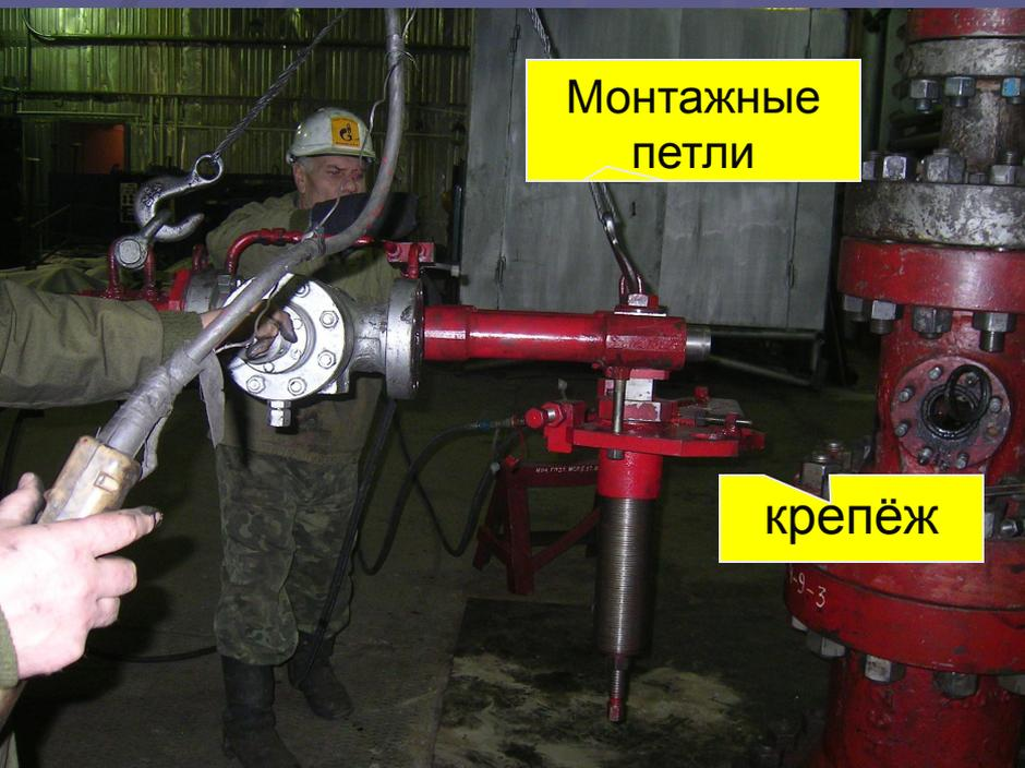
2. Демонтаж с ложного устья и последующий монтаж на аварийном устье отрегулированного приспособления с задвижкой во избежание изменений в корректировке, рекомендуется производить в сборе. Для этого установлен дополнительный крепёж и монтажные петли.
