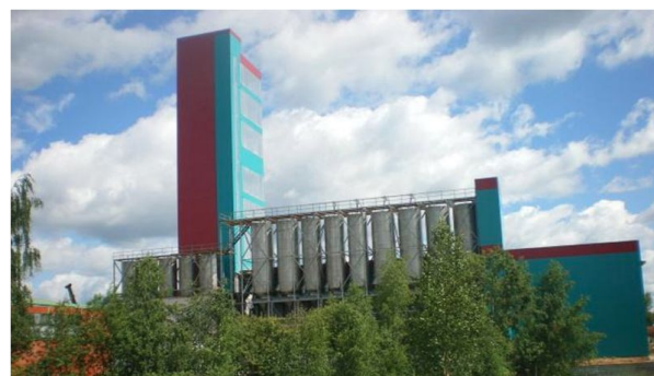
Завод по переработке пластмасс «ПЛАРУС» г. Солыкамск
