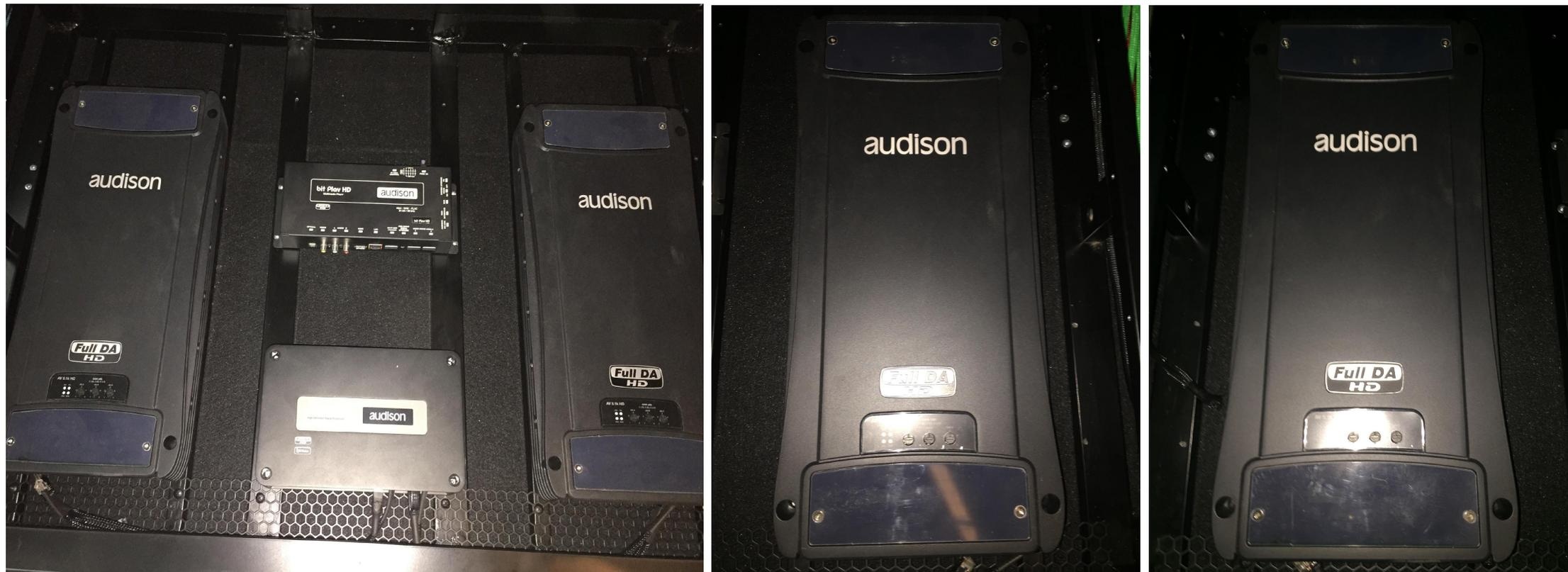
В системе присутствуют 2 усилителя: **Full HD DA Audison AV 5.1K HD**. Оба усилителя имеют **раздельное питание** от дистрибьютера и расположены на **сварной раме под электрическим фальшполом в вентилируемом пространстве с приточной и вытяжной вентиляцией** с закладными и болтовым креплением к сварной раме. Фальшпол надежно защищает проводку от случайного попадания посторонних предметов.
