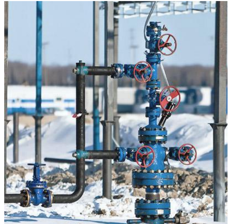
15. Установка фонтанной арматуры
