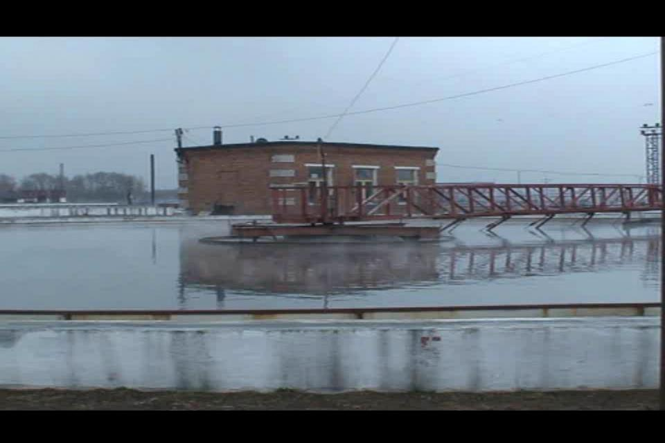
В аэротенке сточная вода смешивается с активным илом, поступающим из регенератора через окна.
