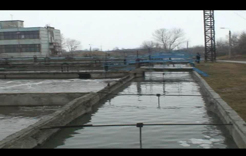
Далее смесь сточной воды и активного ила поступает на вторичные отстойники, которые выполняют функцию осветления биологически очищенной воды и отделения очищенной сточной воды от активного ила.
