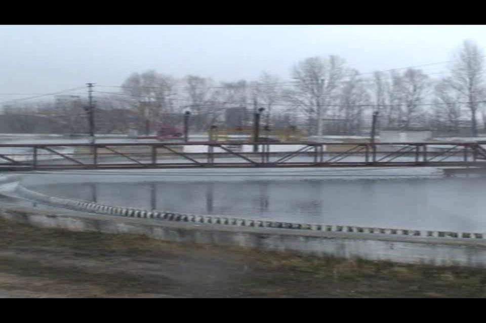
Очищенная сточная вода из вторичных отстойников сбрасывается в Лоток Паршаля, откуда после измерения ее количества и хлорирования направляется через глубоководный выпуск в реку Волга.
