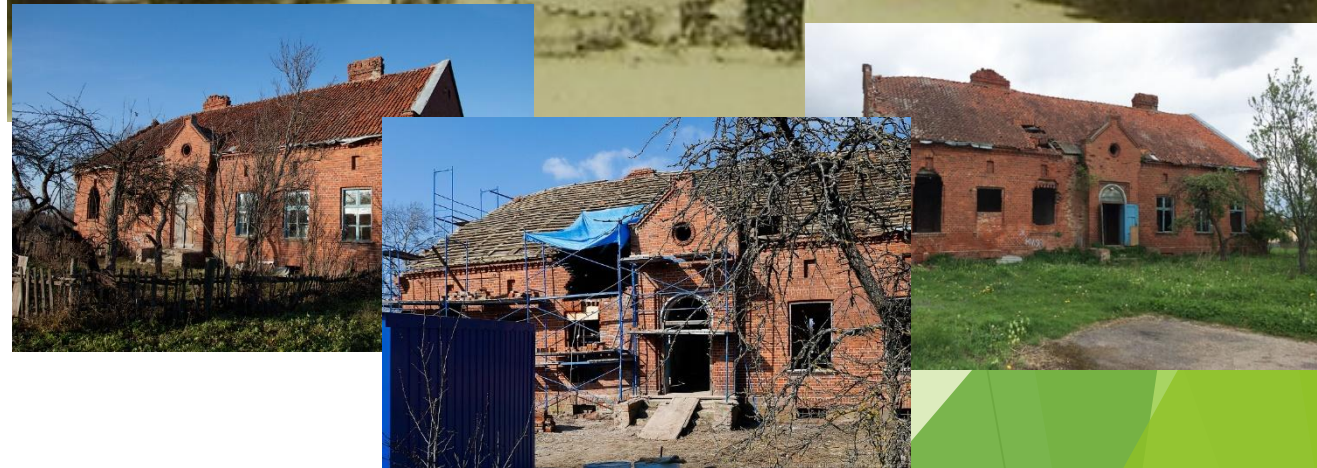
Будинок Канта (Будинок пастора Даніеля Ернста Андерша) Закраз на реконструкції
